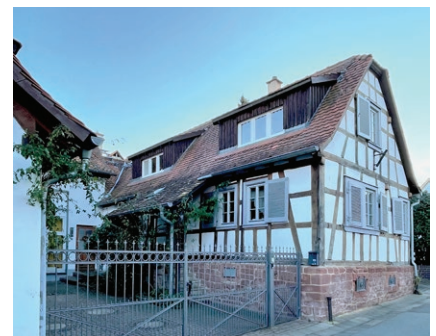
4.55 Saniertes Haus in Lengfeld (Otzberg)
