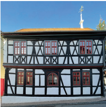
4.20 Fassade des Alten Rathauses in Roßdorf
