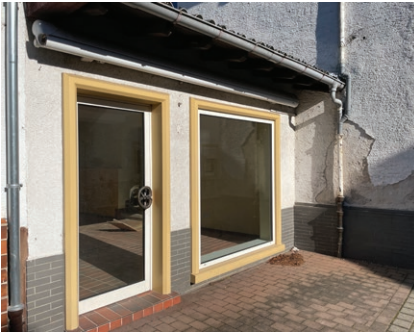
4.30 Leerstehende ehemalige Bäckerei in Eppertshausen
