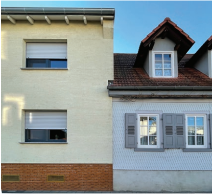
4.45 Ungleiche Nachbarn in Dieburg: Haus des 20. Jahrhunderts mit liegenden Fensterformaten und industriellen Bauprodukten (links) und historisches traditionell verschildertes Fachwerkhaus mit stehenden Fensterformaten und handwerklicher Bauausführung (rechts)
