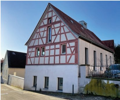
4.73 Sanierung und Teilneubau in Roßdorf
