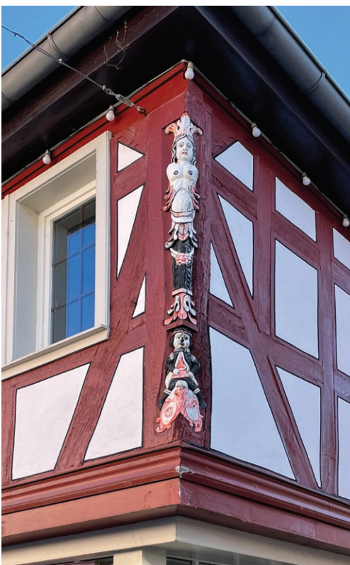
4.17 Detail eines Fachwerkhouses in Dieburg
