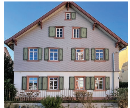
4.54 Saniertes Pfarrhaus in Roßdorf
