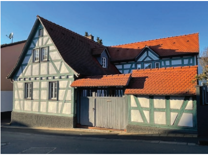
4.37 Sanierte Hofreite in Ober-Ramstadt
