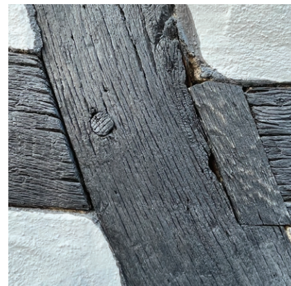
4.26 Detail: Fügung der Balken mit Holznagel am Alten Rathaus in Roßdorf
