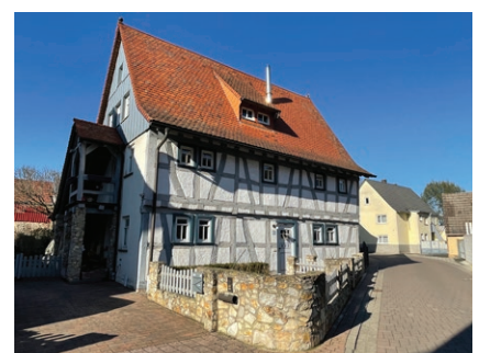
4.14 Denkmalgerechte Sanierung eines Fachwerkhouses in Eppertshausen
