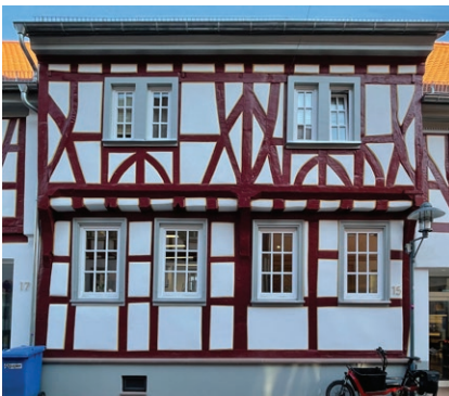
4.75 Sanierter Altbau in Dieburg
