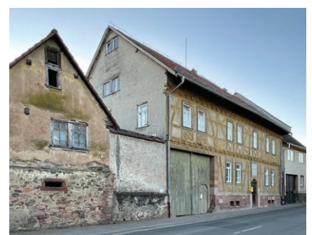
4.64 Bauernhaus mit überbauter Toreinfahrt von ca. 1900 in Ober-Klingen (Otzberg)
