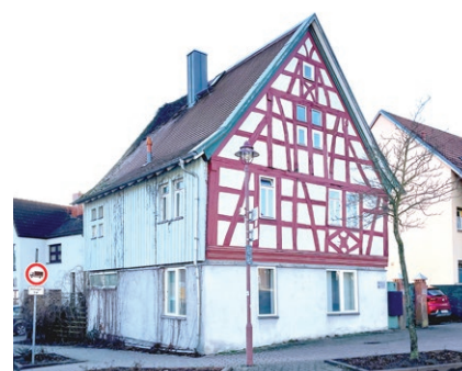
4.28 Saniertes Fachwerkhaus in Roßdorf
